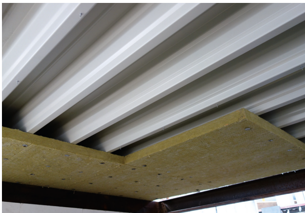
Fig. 24. Isover FireProtect® system til beskyttelse ståltrapez tag er karakteriseret ved lav indbygningshøjde, men også ved enkel montage med svejsepins.
