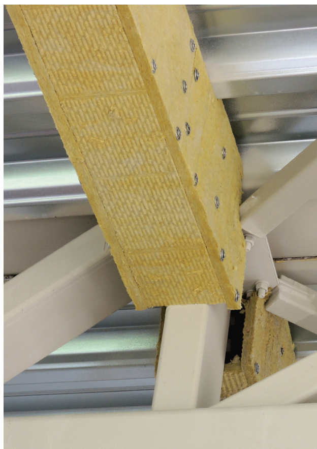
Fig. 26. Bæres taget af en stålkonstruktion, skal denne også brandbeskyttes, så der opnås den ønskede bæreevne. OBS. Ved afslutningen af det brandbeskyttede område skal passtykkerne over profilet tildannes, så de udfylder hele åbningen under trapezprofilet.
