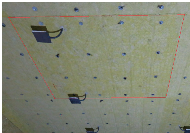
Fig. 25. Pins placeres langs bunden af bølgen med indbyrdes afstand maks. 300 mm, og med maks. 75 mm fra nærmeste pin til pladekanten. Forbruget er ca. 12-16 pins pr. m 2 afhængigt af trapezpladens geometri.
